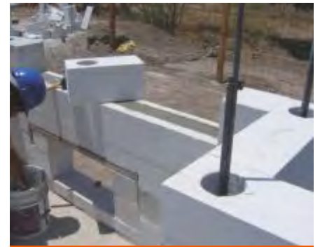
Fig. 21 Refuerzo vertical y horizontal de mampostería.
