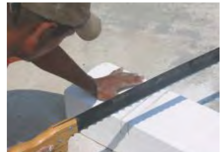
Fig. 22A: Corte con serrucho.
