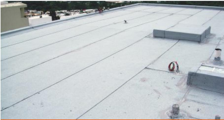
Fig. 17: Impermeabilizante tipo membrana SBS.
