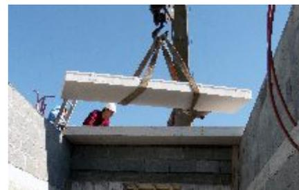
Fig. 8: Elevación de Panel de Losa.
