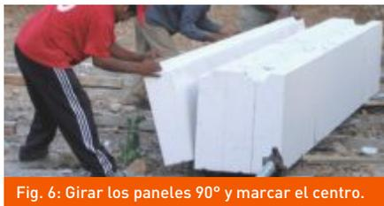
Fig. 6: Girar los paneles 90° y marcar el centro.
