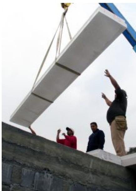
Fig. 4: Uso de eslingas de carga.
