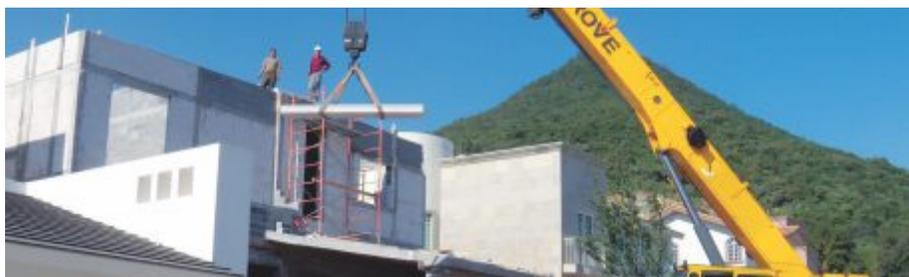
Fig. 7: Instalación de Panel de Azotea con eslinga.
