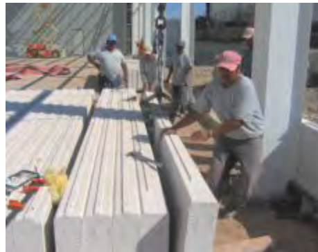
Fig. 8a / 8b: Colocar la tenaza al centro del panel y moverlo a la posición de instalación.
