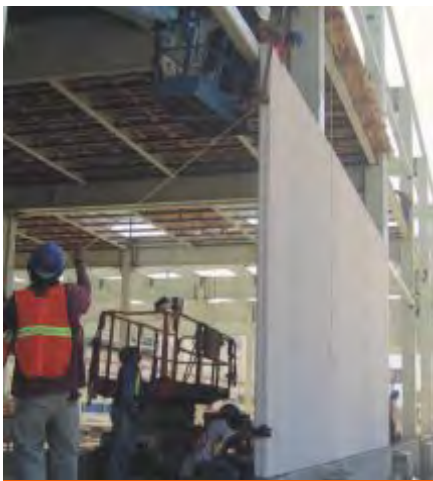
Fig. 17: Nivelar, alinear y plomear cada panel.
