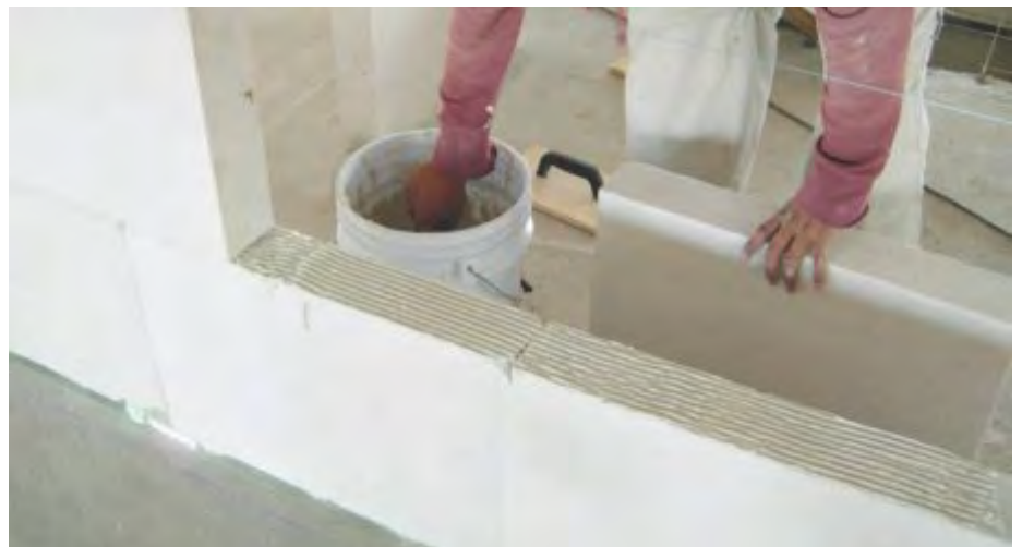
Fig. 8: Aplicación de Adhesivo Hebel.
