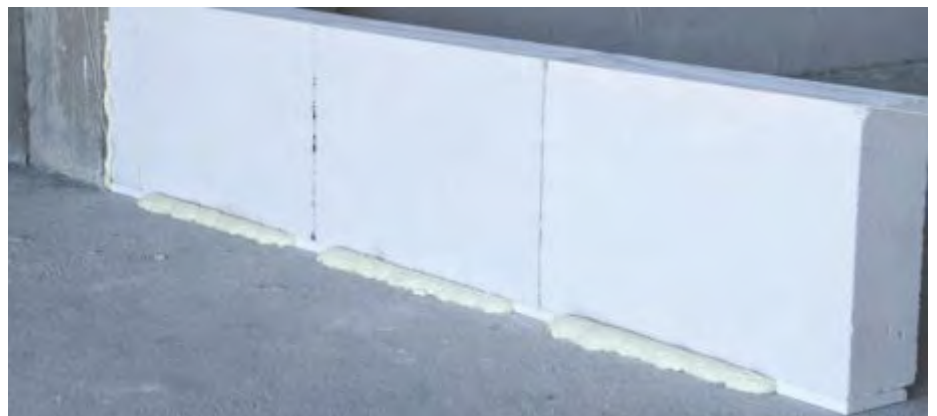
Fig. 6: Expansión de espuma de poliuretano en desplante.
