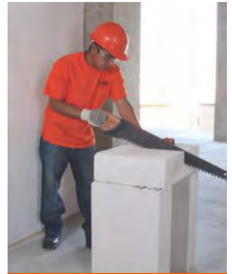
Fig. 9: Corte con serrucho Hebel.
