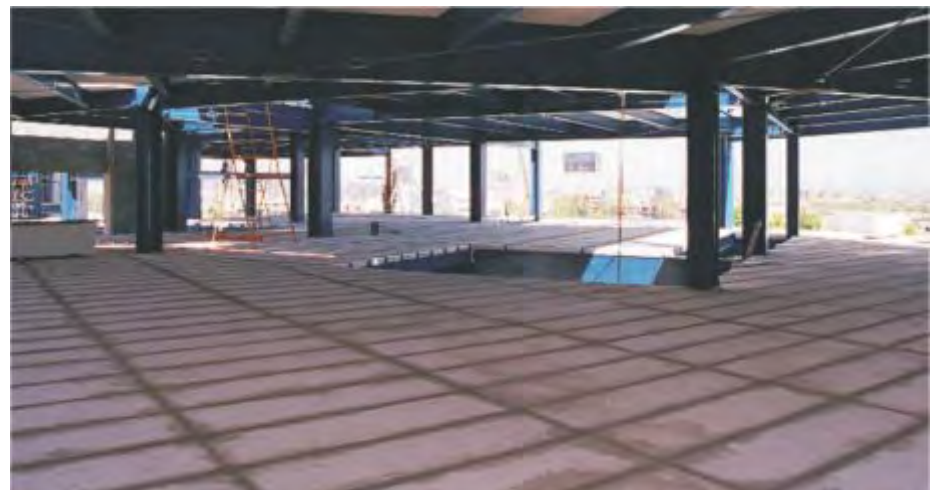
Fig. 25: Junta superior entre paneles coladas y afinadas.
