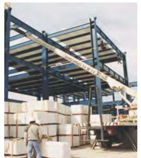
Fig. 2: Almacenamiento de panel Hebel en obra.
