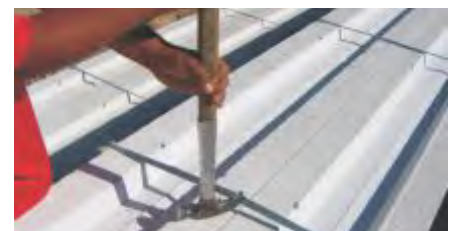
Fig. 4: Desflejado de paquetes de paneles.
