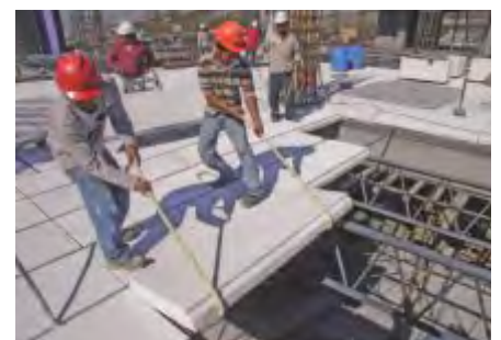
Fig. 9: Una vez colocado el panel se retiran las cuerdas y se empuja a tope con el anterior.
