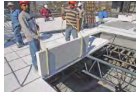
Fig. 7: Acercar el panel a su posición final en losa.
