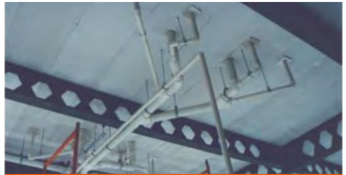
Fig. 20: Instalaciones sanitarias en nivel inferior de losa.
