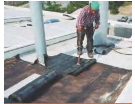
Fig. 22: Impermeabilización de membrana.
