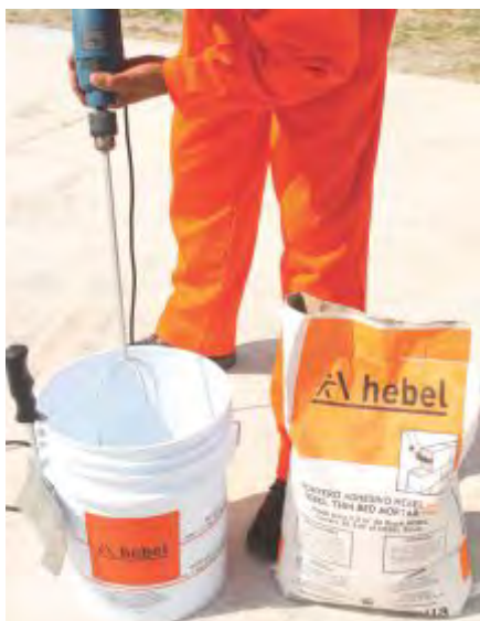
Fig. 7 Preparación de Adhesivo Hebel®.
