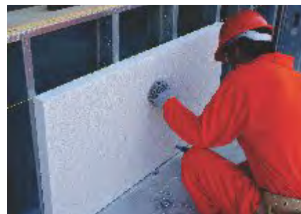
Fig. 10 Atornillado en postes centrales.
