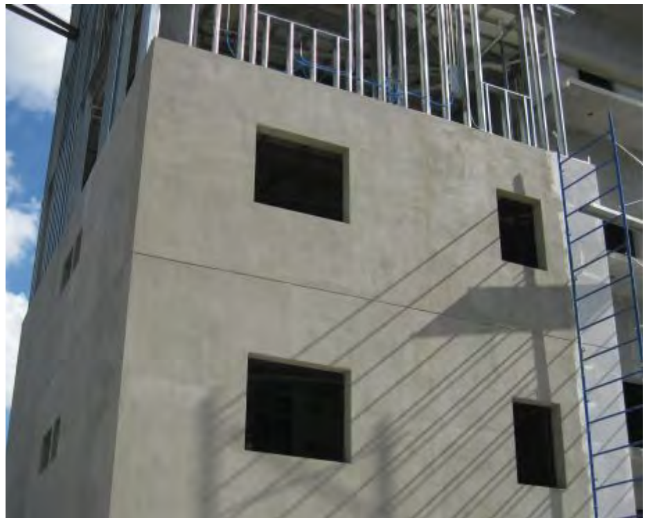
Fig. 19 Tablero de Hebel® Power Panel con acabado.
