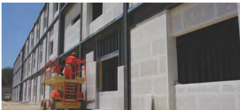
Fig. 18 Tablero de Hebel® Power Panel instalado.
