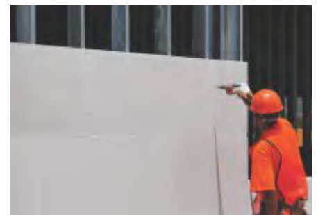
Fig. 13 Instalación de hiladas superiores.
